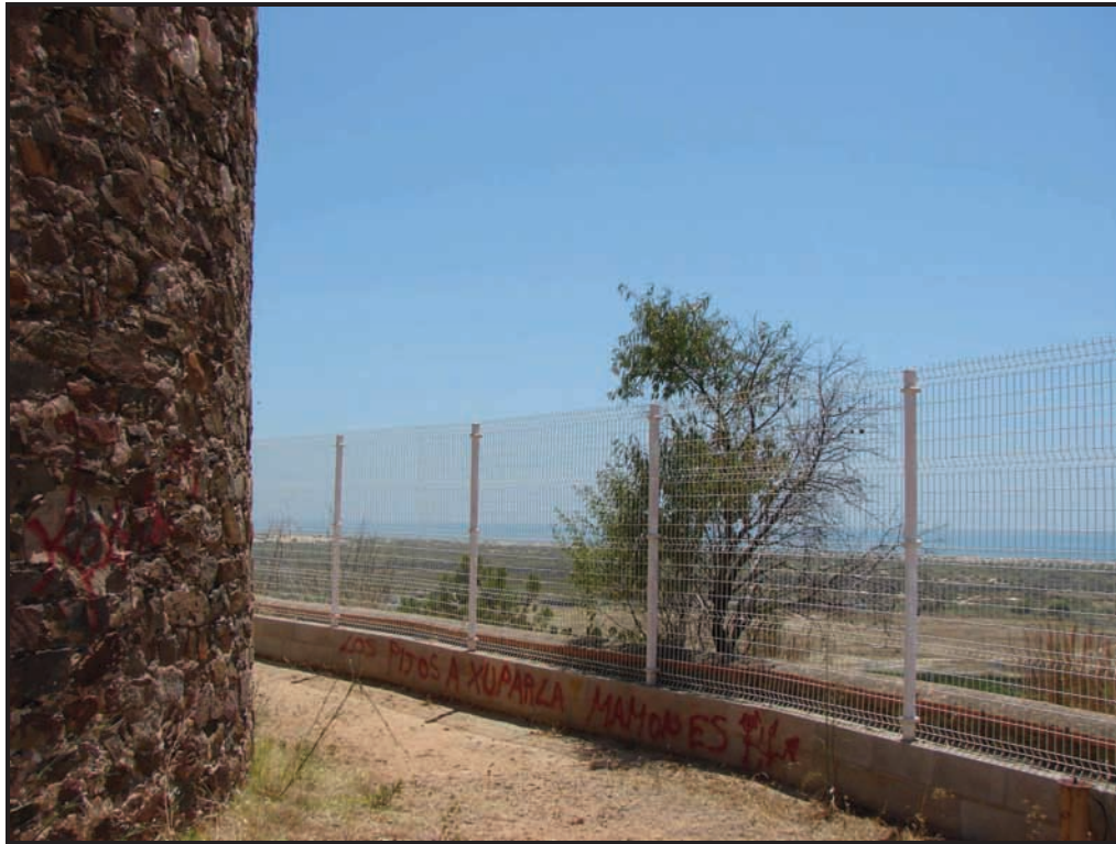
Detalle de la valla de protección que contamina, también, la percepción del espacio.
