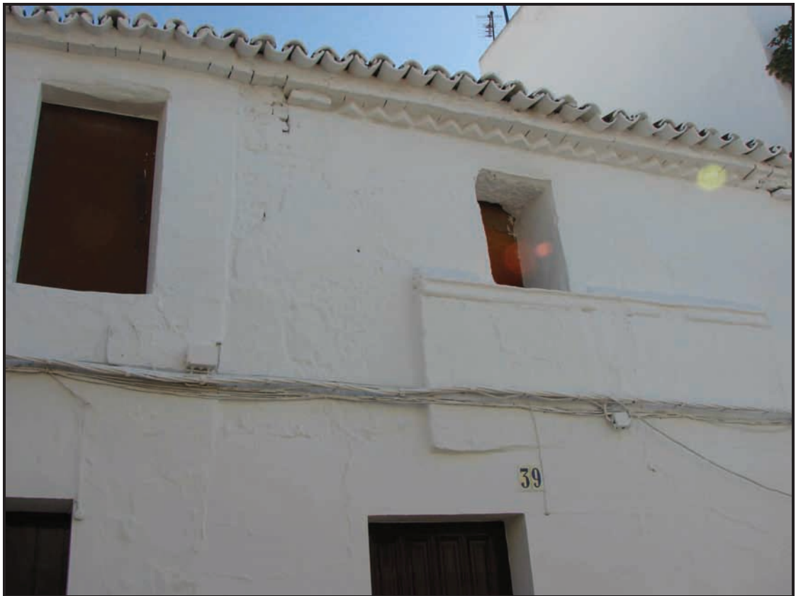
Foto 5. Detalle de la unión entre ambas fachadas. Puede observarse que la más antigua corresponde al número 39, con un enjabelgado diferente, los restos de la cornisa, el pequeño ventanuco del “doblao” que denuncia muros más gruesos en la construcción. Como remate decorativo, el número 39 posee un friso en zigzag que el número 37 no conservó.
