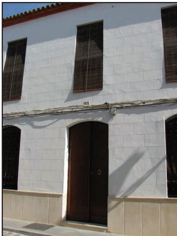
Foto 2. Detalle del juego de la terminación de los huecos en las diferentes alturas: adintelada en la superior, arco rebajado en la inferior.
