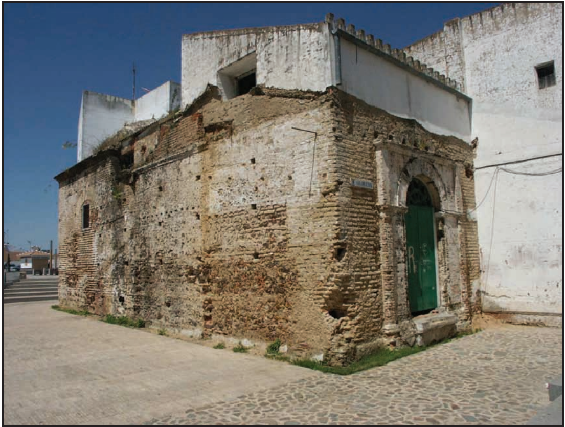
Foto 1. Estado de la edificación en 2004, conservando el añadido de la segunda planta y anexado al ya perdido almacén de higos y almendras.
