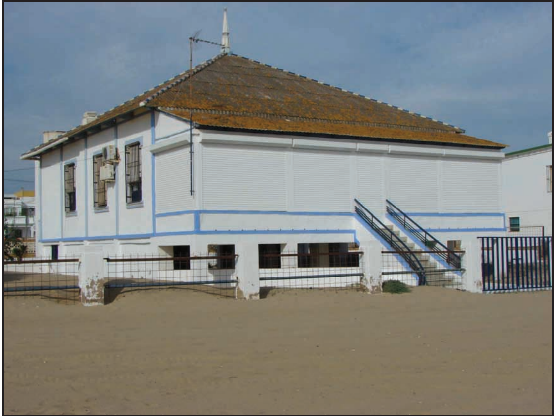
Foto 3. Lateral y parte posterior de la casa que da a la playa. Obsérvese cómo se ha cerrado la terraza original e integrado dentro de la casa.
