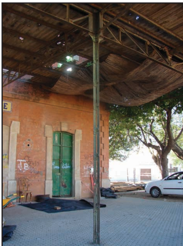
Foto 5. Detalle del pilar central de apoyo de la marquesina.
