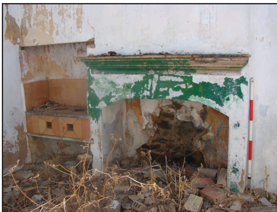
Estancia aneja. Cocina/salón de una de las viviendas de los aparceros dentro del mismo cortijo.
