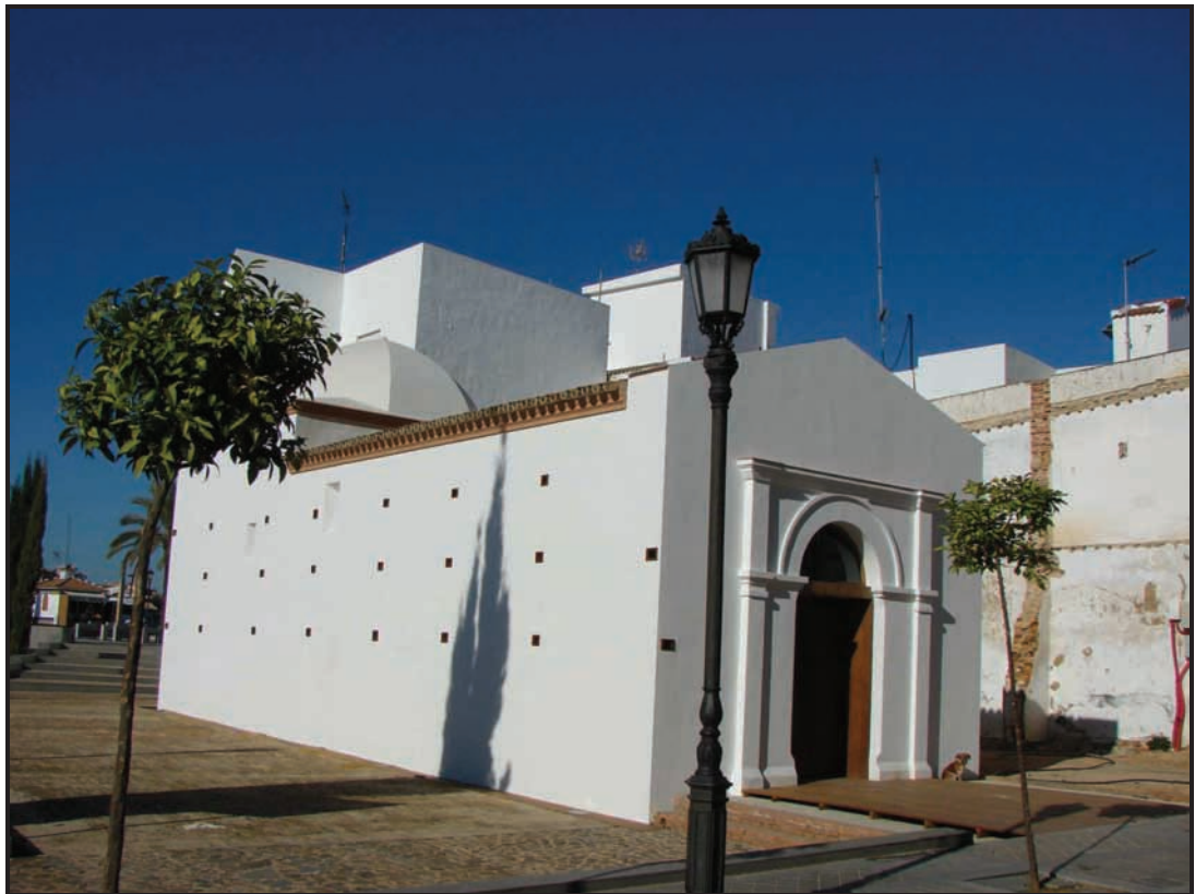
Foto 2. Estado actual de la edificación completamente rehabilitada.
