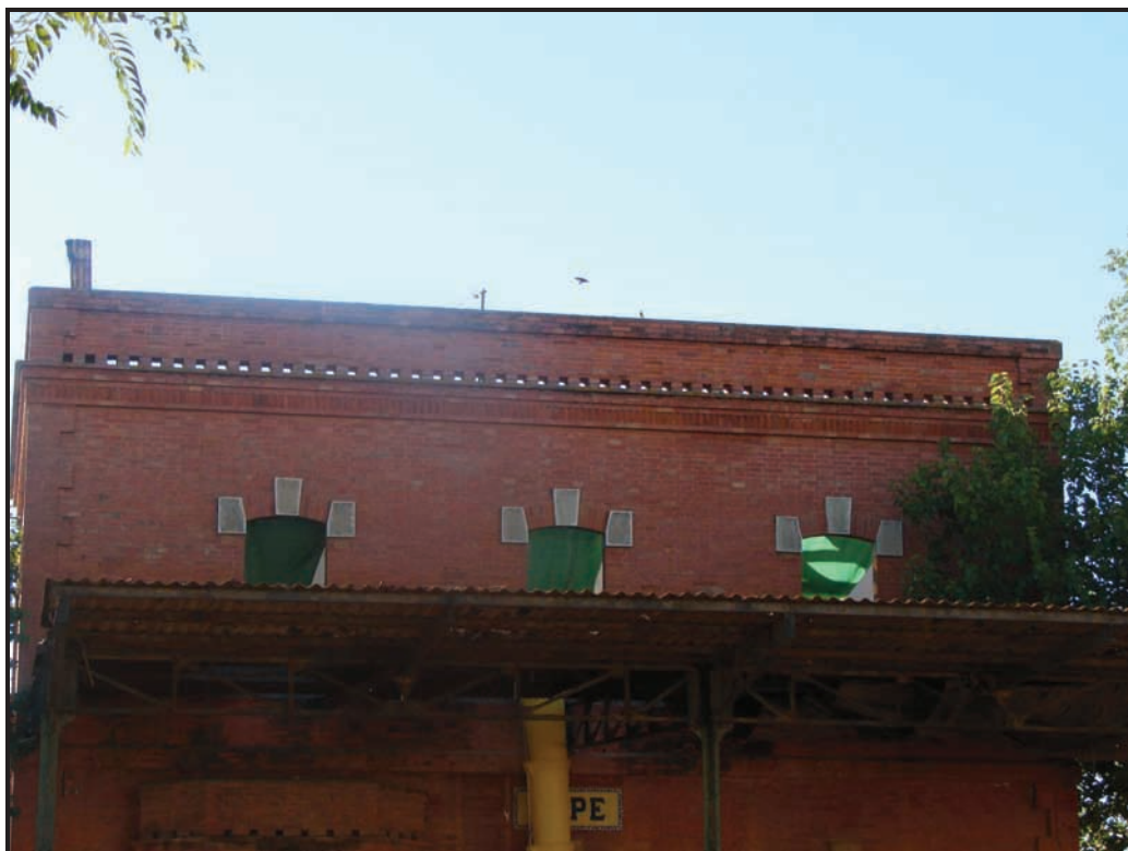
Foto 3. Detalle de las ventanas del segundo piso y el pretil de cierre.
