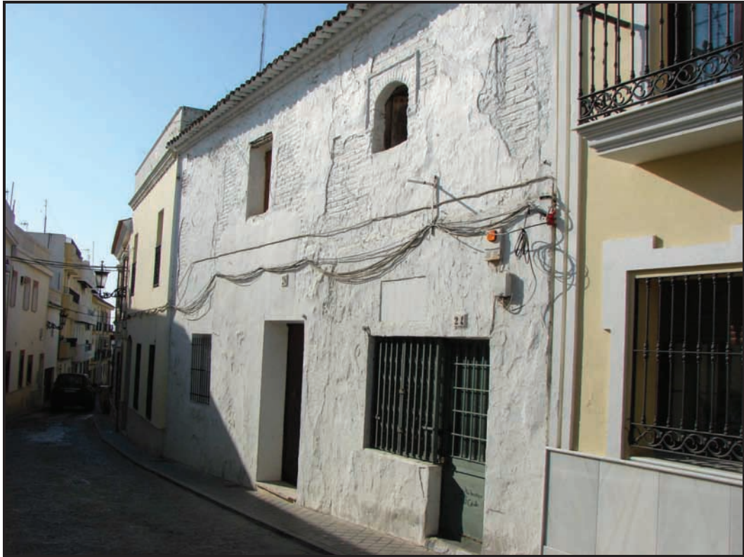
Foto 1. Vista general del inmueble.
