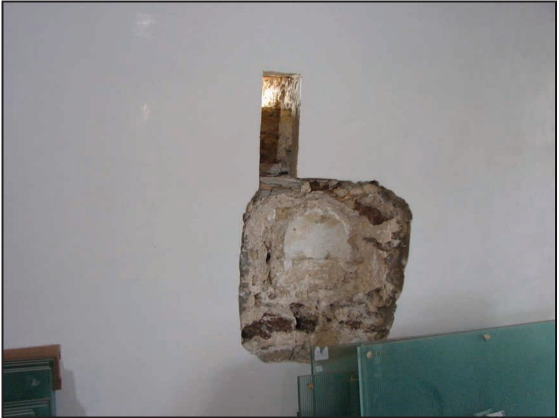
Foto 8. Restos de la pila de agua bendita y su soporte en el muro Norte de la nave.
