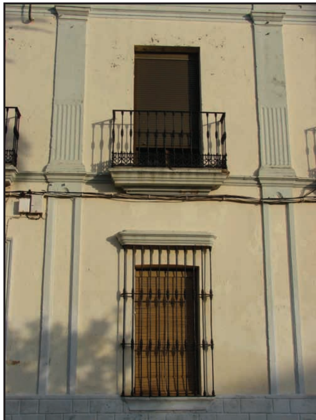
Foto 4. Detalle de la utilización del diseño del enrejado en las ventanas de la planta baja y de balcón en los huecos de la planta superior.
