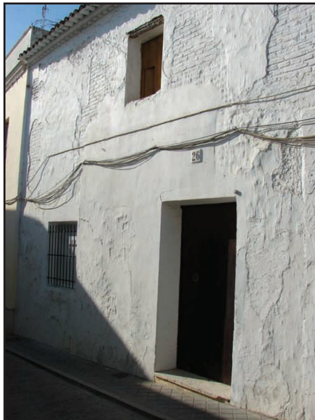
Foto 4. Detalle de parte de la fachada que accede a la vivienda.
