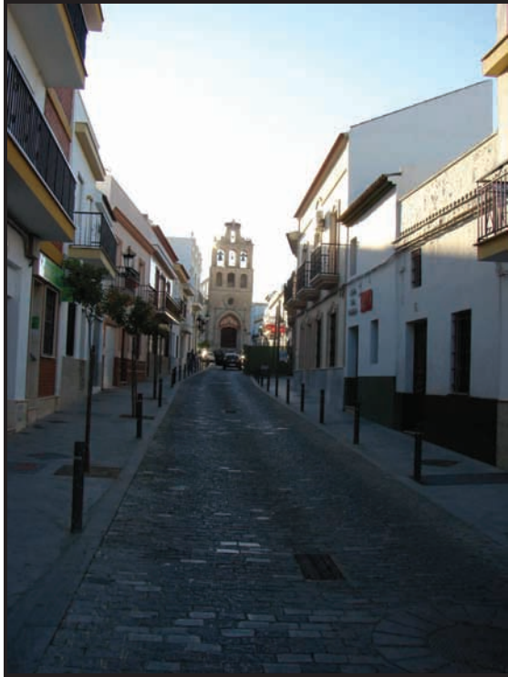
Foto 1. Vista general desde la calle Iglesia.
