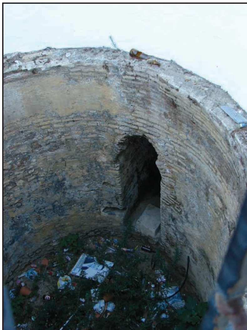
Foto 3. Detalle del interior de la Fuente, cegada y colmatada por basuras. Es sumamente interesante la puerta de acceso al pozo interior con ese arco de impronta fuertemente musulmana, claro ejemplo de las pervivencias del lenguaje artístico mudéjar a lo largo de los siglos en Lepe.
