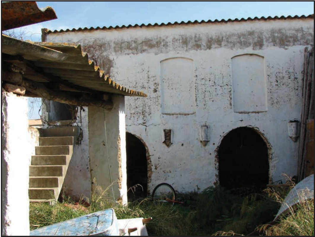
Foto 3. Patio del nº 15. Restos de la cuadra y escalera de acceso al soberao a la izquierda.
