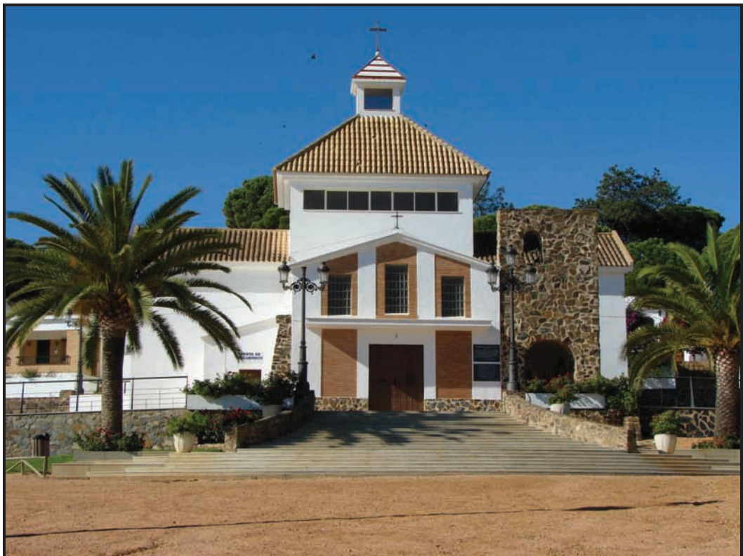
Foto 2. Detalle de la fachada.
