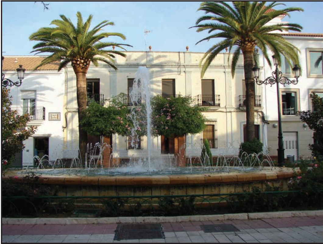
Foto 1. Vista general de la fachada.
