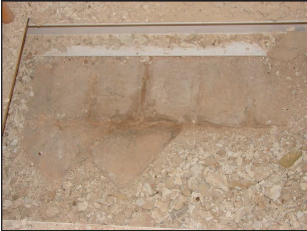
Foto 10. Restos de la solería original de barro cocido en el muro Sur del presbiterio.
