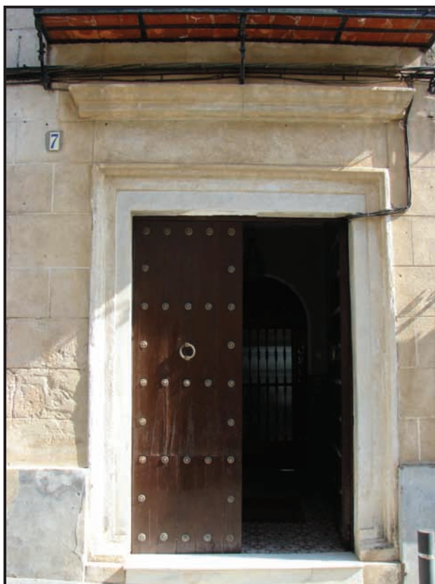
Foto 3. Detalle de la puerta principal de la vivienda que da acceso al patio.
