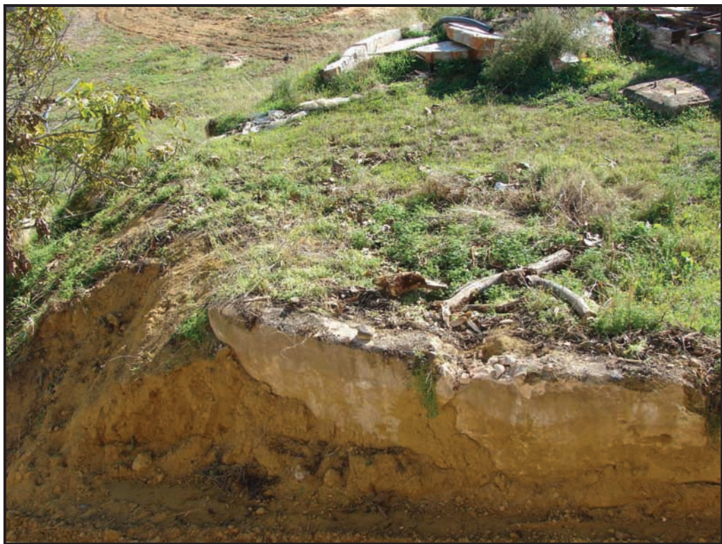
Foto 4. Detalle del muro revestido de cal de la plataforma.
