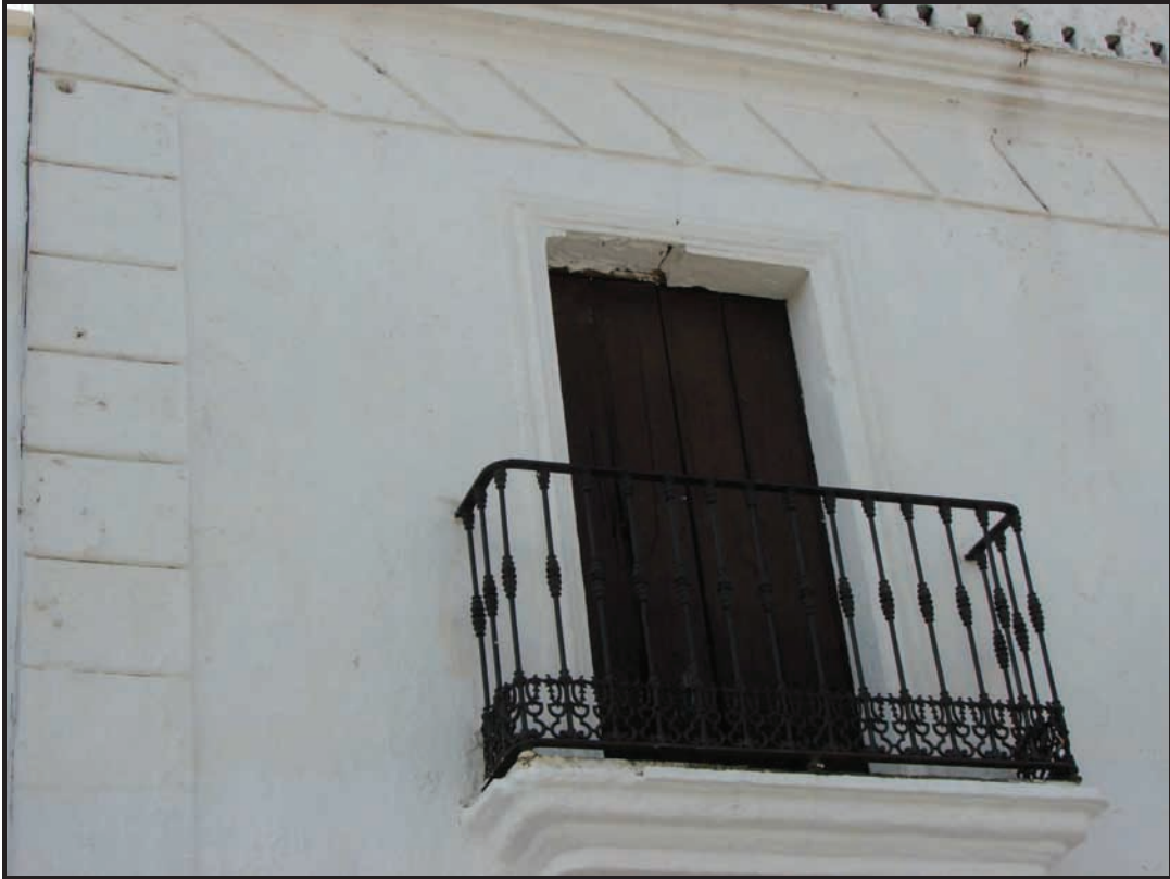
Foto 3. Detalle del friso de enmarque de la fachada y de las contraventanas originales de la vivienda.
