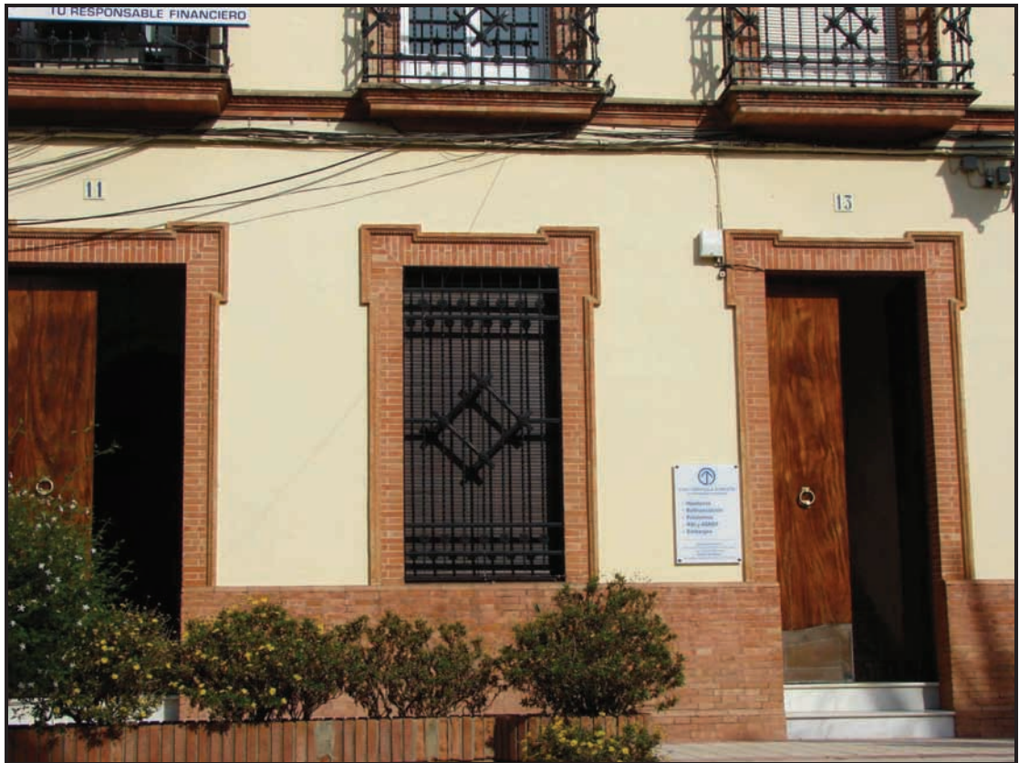
Foto 3. Detalle de la utilización del ladrillo visto como ornamentación en zócalos y huecos.
