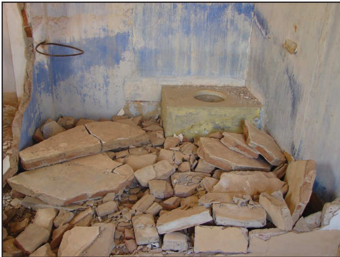
Cuarto de baño de una casa de casado. Obsérvese el fino grosor de las paredes.
