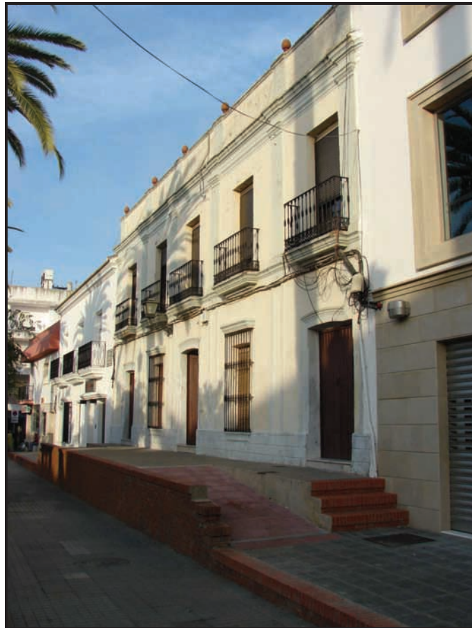
Foto 2. Detalle de la diferencia de altura entre la casa y los inmuebles que la enmarcan.
