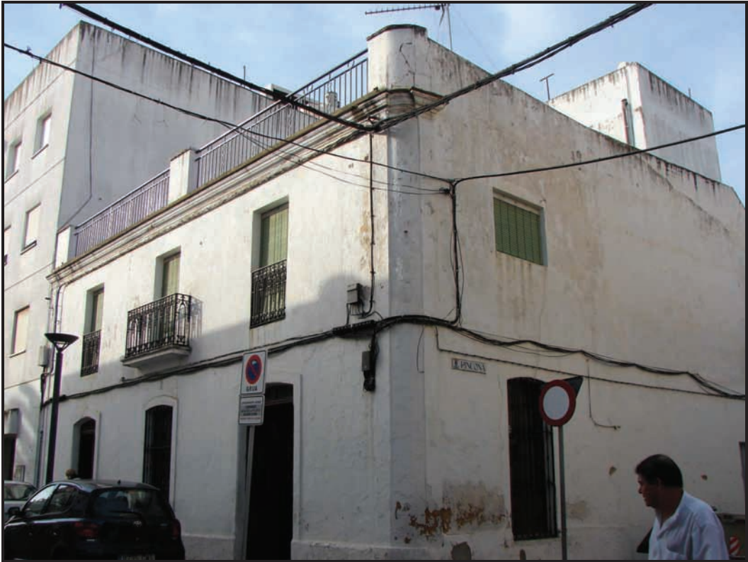
Foto 1. Vista general de la vivienda. Obsérvese el achaflanamiento de la esquina y la contaminación visual de cables y tendido eléctrico vario.
