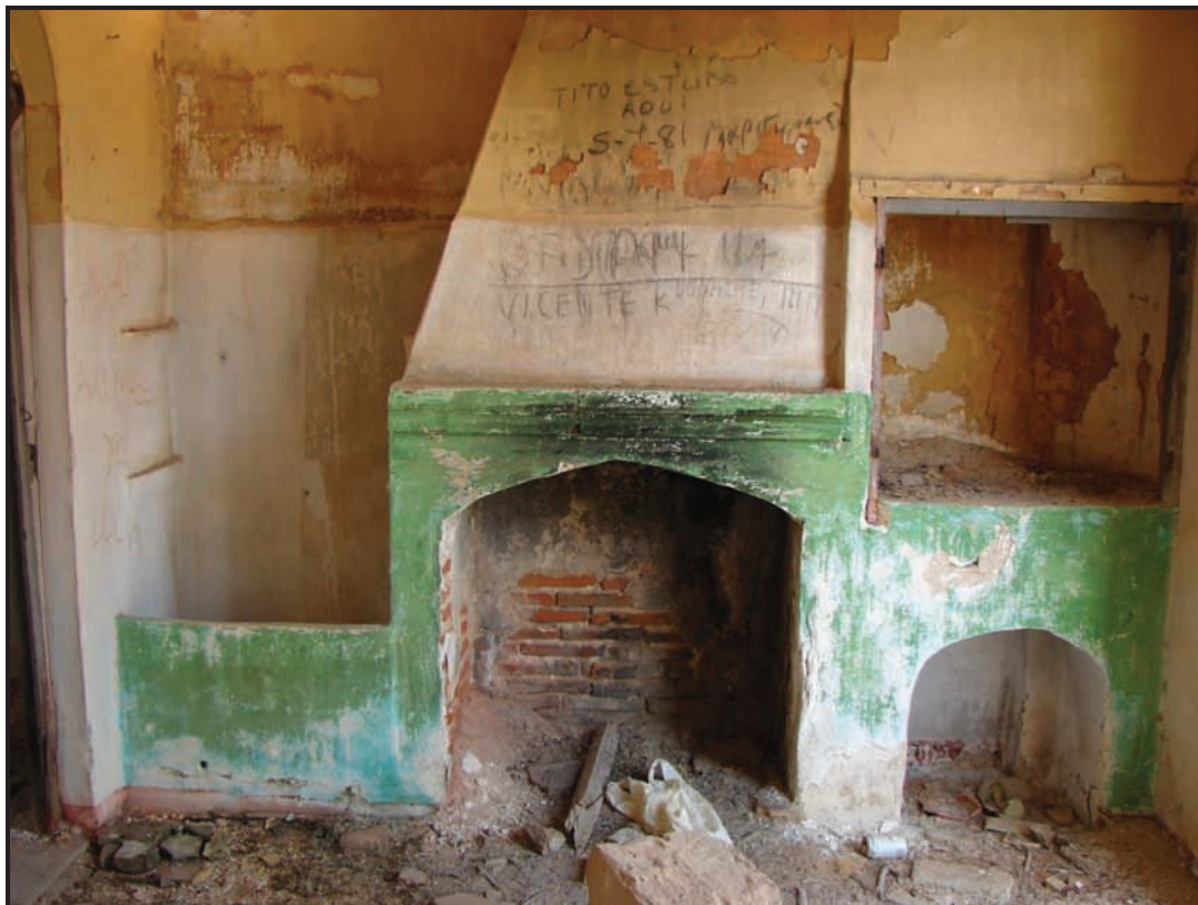
Interior de una de las casas de los casados.
