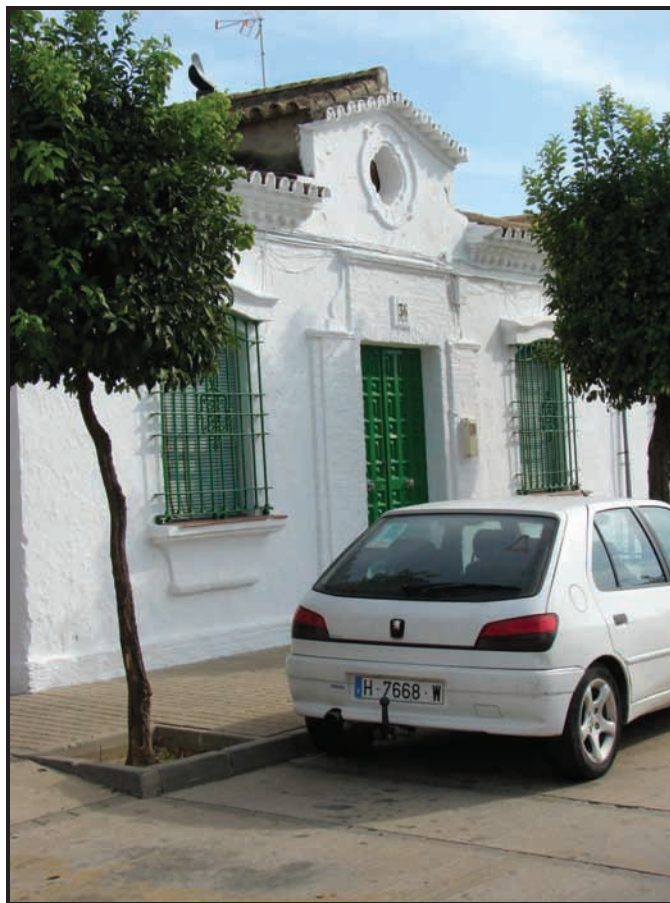
Foto 2. Detalle de una de las pocas fachadas originales que se mantienen.
