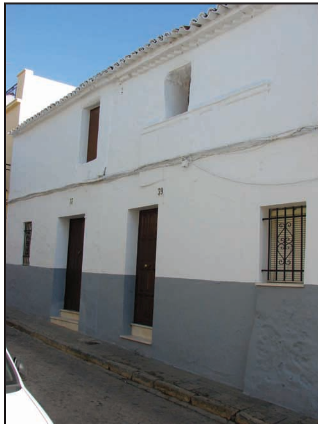
Foto 2. Detalle de la fachada de ambas viviendas. Obsérvese la simetría de los huecos.
