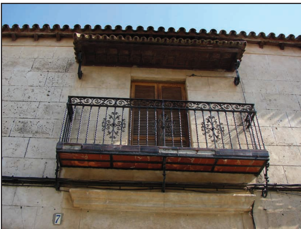
Foto 2. Detalle del balcón con marquesina de teja que decora la fachada.
