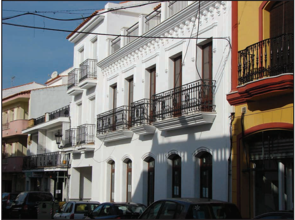
Foto 1. Vista general de la fachada en la que puede observarse el juego de los cierres de los huecos: adintelado en el superior, de medio arco en el inferior.
