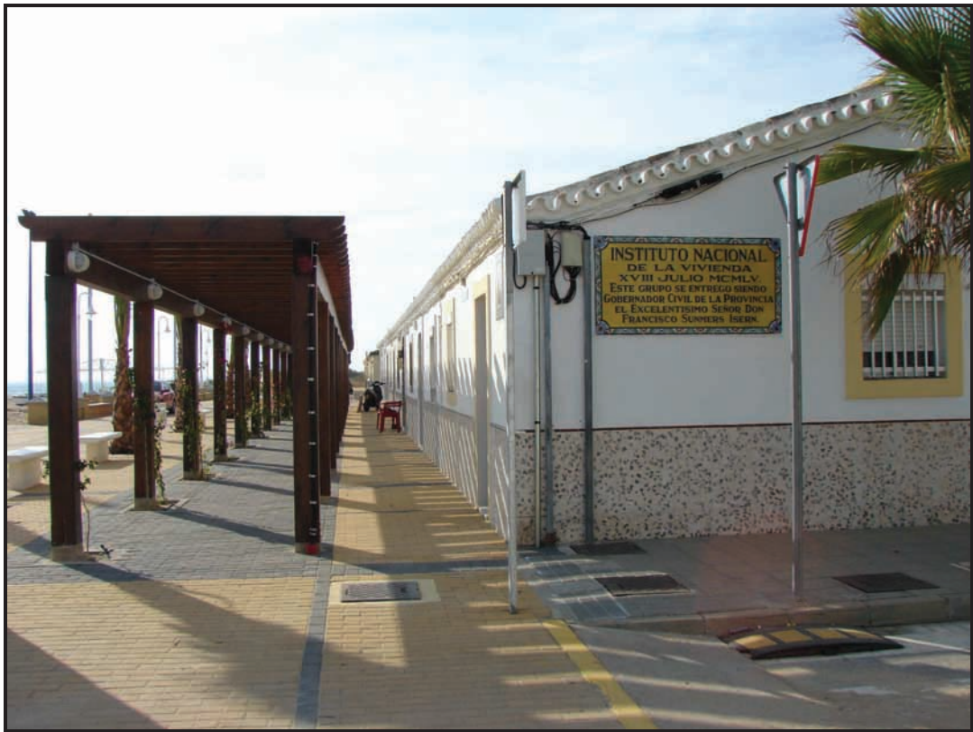
Foto 1. Detalle de uno de los conjuntos de viviendas mirando hacia el actual Paseo Marítimo y el mar.
