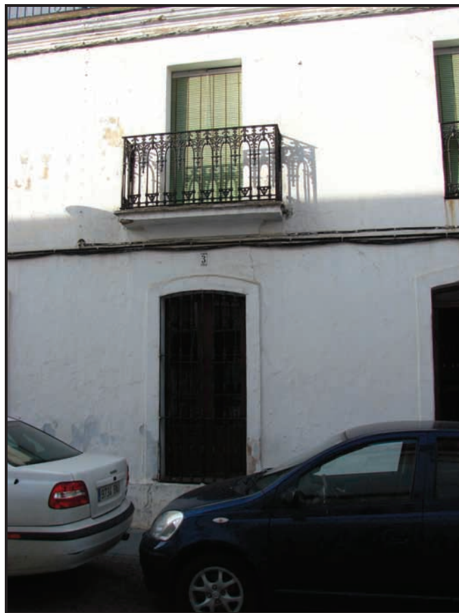
Foto 2. Detalle del juego decorativo del adintelamiento para el piso superior y el semiarco para el inferior.
