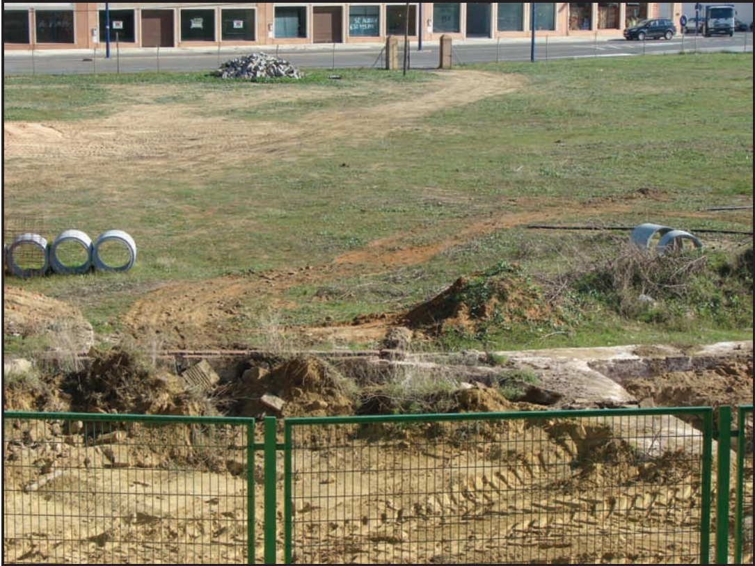
Foto 7. Detalle del canal y su conexión con la balsa.
