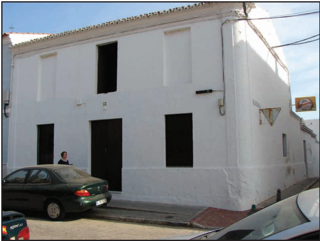
Foto 1. Vista general del inmueble. Juego de vanos abiertos y cerrados en fachada.
