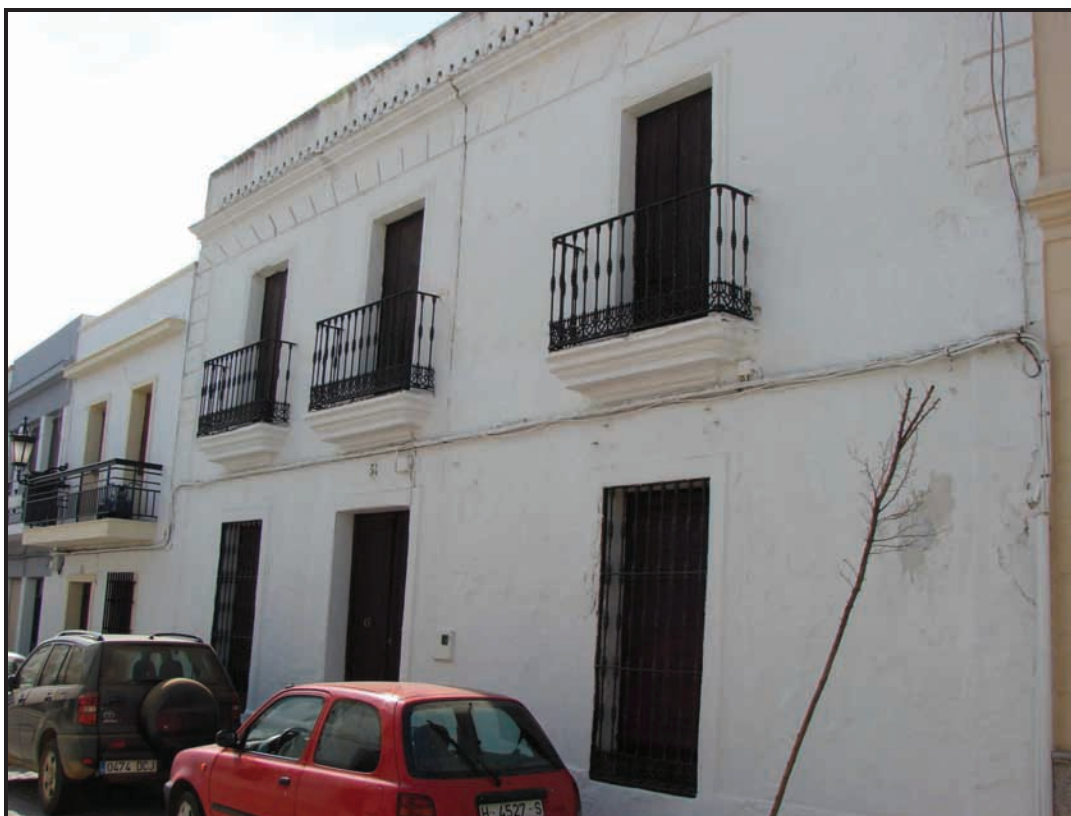
Foto 1. Vista general de la vivienda.
