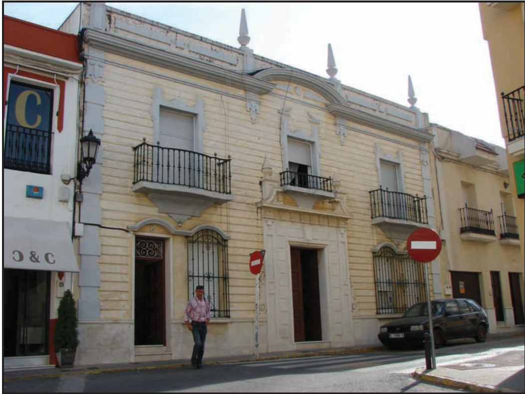
Foto 1. Vista general del inmueble.
