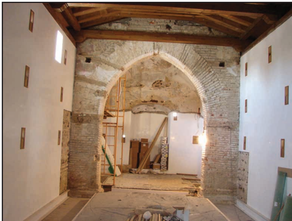
Foto 5. Interior de la nave durante el proceso de rehabilitación, obsérvese el gran arco apuntado que separa los dos espacios religiosos.
