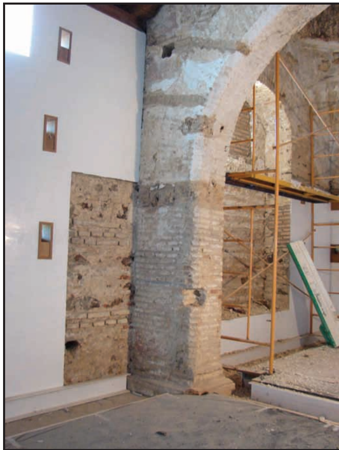
Foto 11. Detalle de parte del arco y muro Sur. Obsérvese el fragmento murario al descubierto en el que puede verse el sistema constructivo original con las hiladas de ladrillo entre tongadas de tapial.
