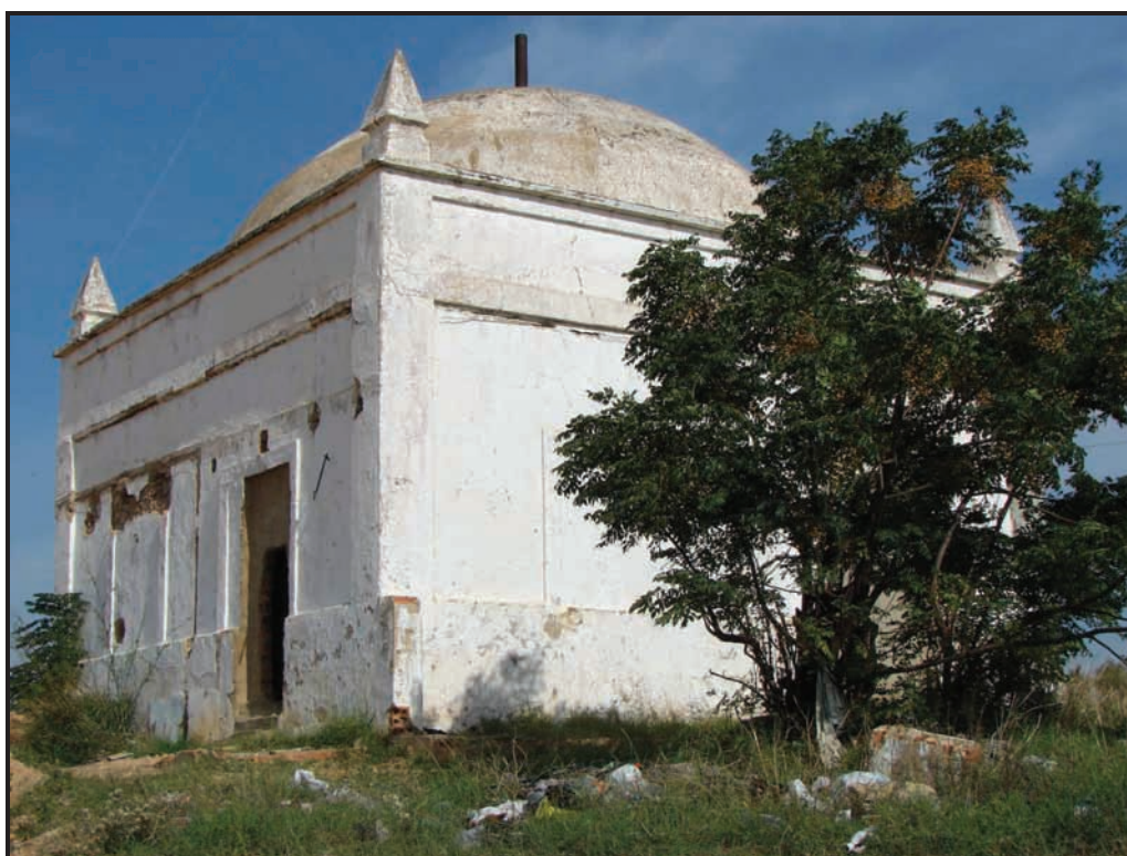
Foto 2. Detalle de la entrada al bien inmueble.
