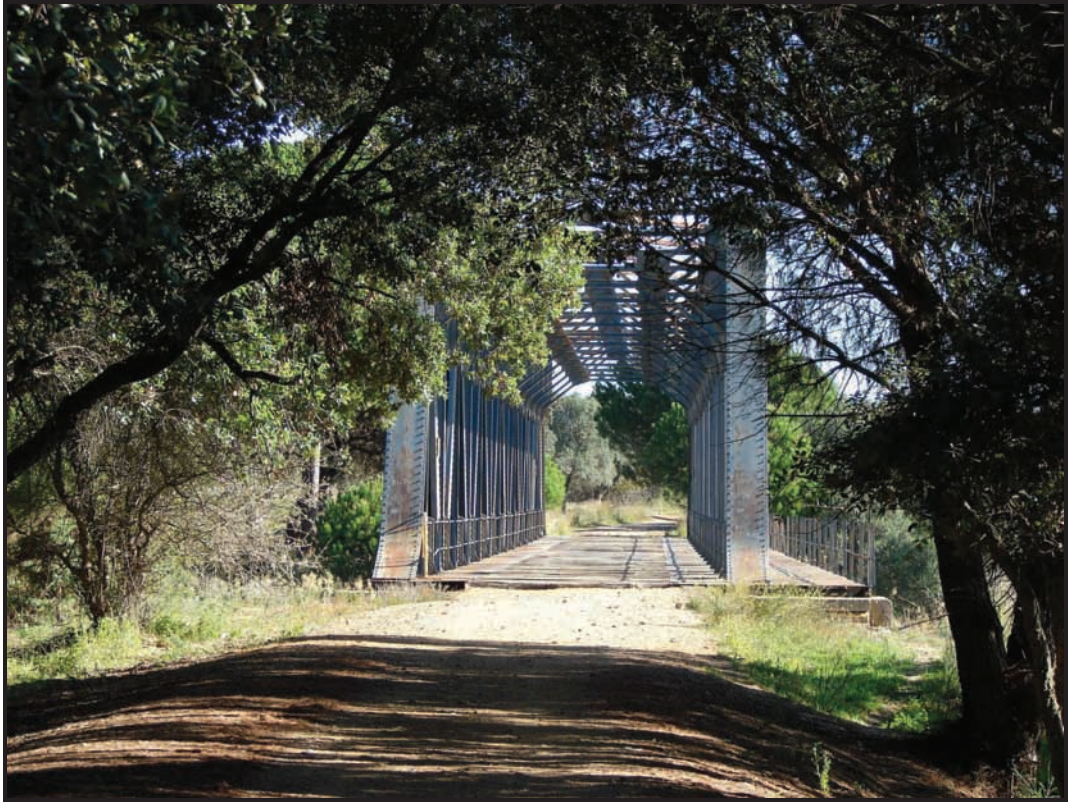
Foto 1. La Vía Verde desembocando en el puente.
