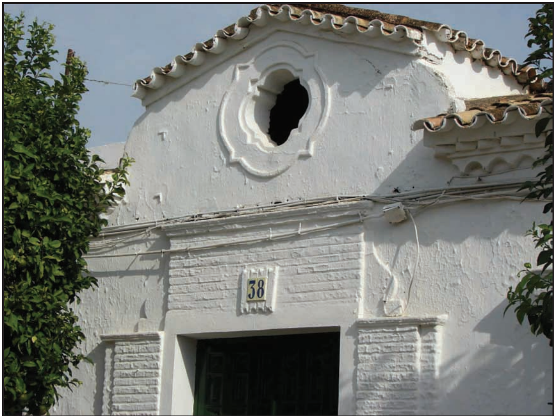
Foto 3. Detalle del frontón de cierre de la fachada con doble función: elemento decorativo que rompe la linealidad y hueco de entrada de luz al acceso de la vivienda.
