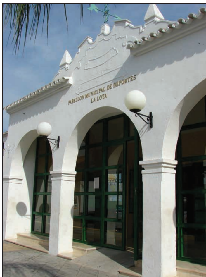
Foto 2. Detalle de la portada de acceso.
