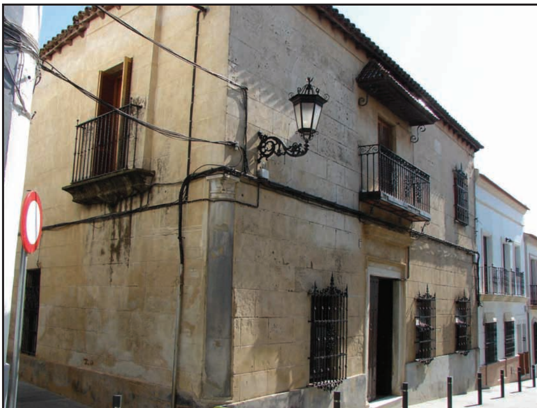
Foto 1. Vista general del edificio.
