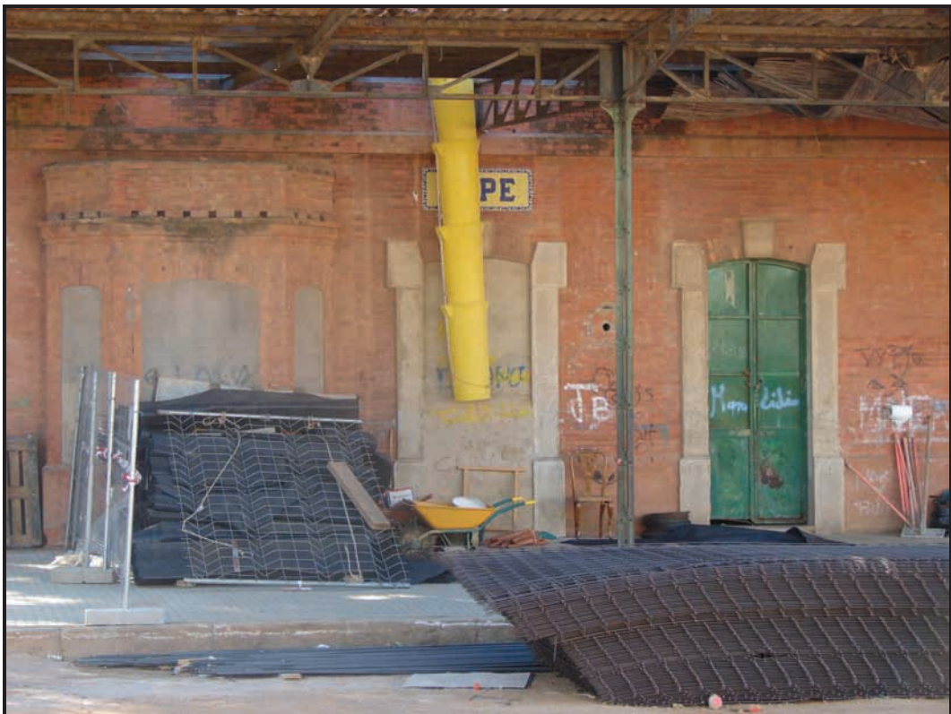
Foto 2. Detalle de las puertas de acceso a la oficina del jefe de la estación, a la sala de espera y a la vía (de izqda. a dcha.)
