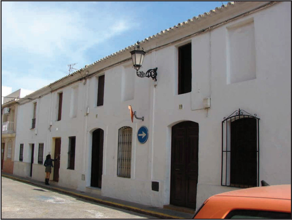
Foto 1. Vista general de las viviendas.
