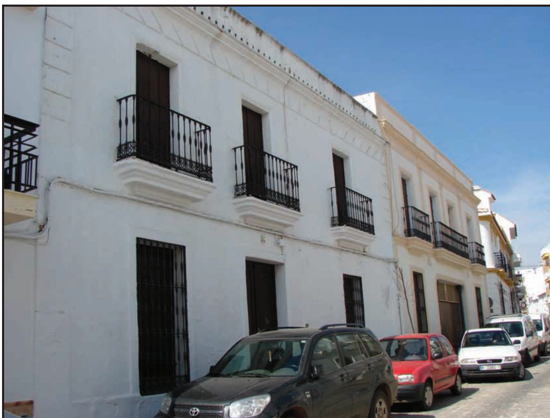
Foto 2. Ubicación de la vivienda junto al número 52, repitiendo el esquema compositivo de la fachada. Con el añadido de los cables exteriores.
